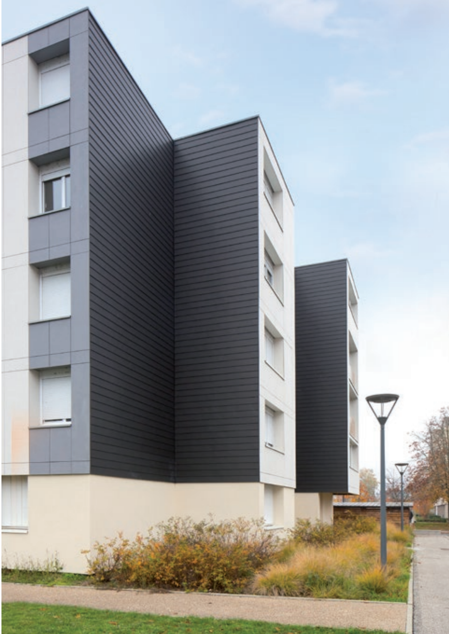
1 Logements collectifs, Clermont-Ferrand (France) - Architecte : Atelier Imagine - Technique : VMZ Joint debout, VMZ Composite et VMZ Profil sinus en QUARTZ-ZINC® et PIGMENTO® rouge terre 2 Logements collectifs, Moulins (France) - Architecte : Didier Allibert Architecture - Technique : VMZ Clin en QUARTZ-ZINC®, ANTHRA-ZINC® et AZENGAR®
